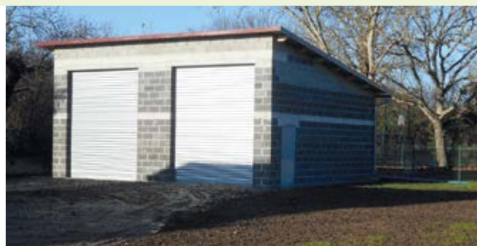
Construction de garages à l'arrière des ateliers municipaux
