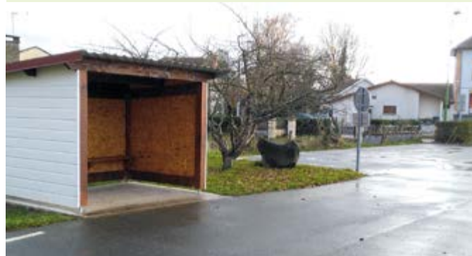
Réaménagement parking école et création abri de bus scolaire
